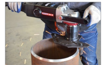
Anfasen von Rohren
