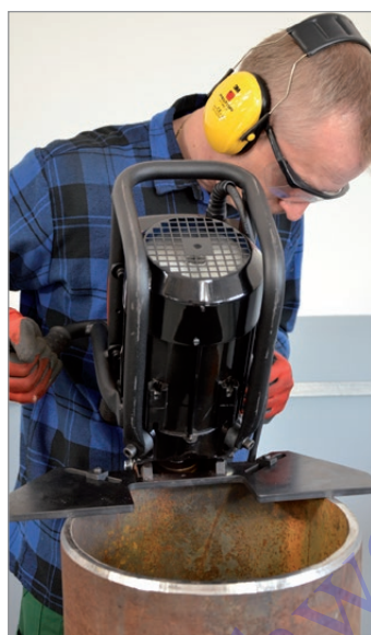
Anfasen von Rohren
