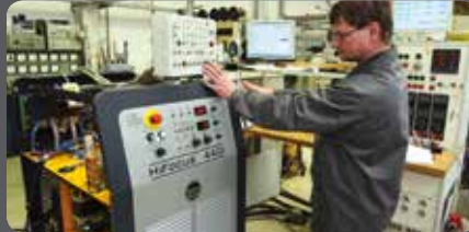
Prüffeld | Testing field
